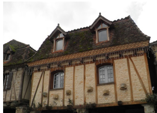
Couverts p 236 et 189 : à noter le pan de bois à écharpe et traverses ainsi que les baies en arc segmentaires.
