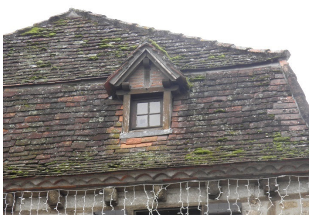
Exemple de toits à combles brisés soulignés d'une génoise. A noter que, dans le premier exemple les abouts de solives destinés à supporter les chevrons en débord ont été sectionnés pour permettre la mise en œuvre d'une génoise.
