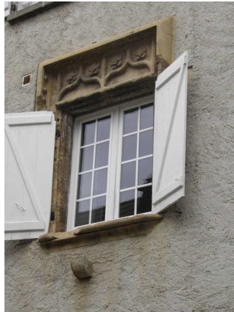
Maison p 214 (rue de la Guierle) : le rez-de-chaussée conserve deux arcades ainsi qu'une porte piétonne masquée par l'enduit, tandis que l'étage est percé d'une croisée surmontée d'accolades agrémentée de rose, motif récurrent du XV ème siècle. A noter la présence de corbeaux indiquant sans doute la présence d'un auvent attestant de la fonction commerciale du Rez-de-chaussée.
