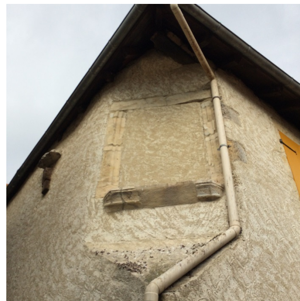
Maison p 304 (angle de la rue de la Boucherie et du moulin Banier) conservant une croisée moulurée disposée dans un angle (remploi?).
