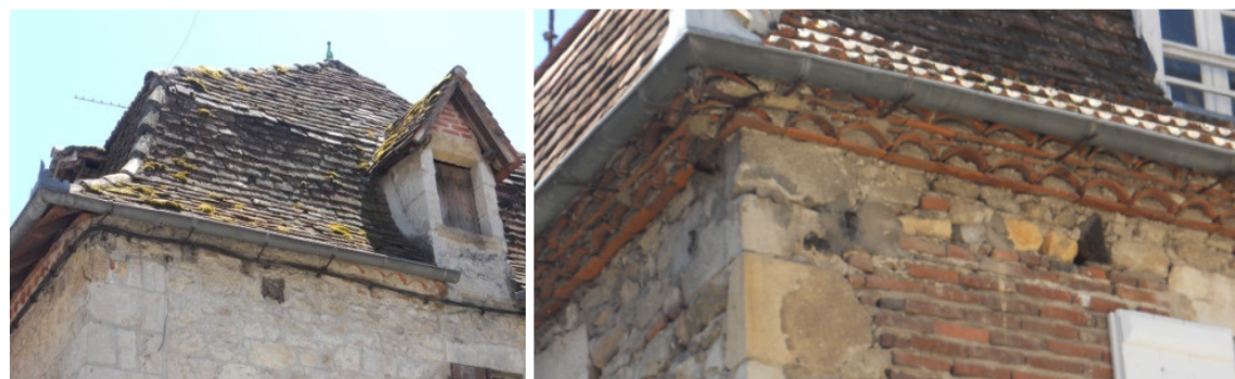
Exemple de toits à combles brisés soulignés d'une génoise. A noter que, dans le premier exemple les abouts de solives destinés à supporter les chevrons en débord ont été sectionnés pour permettre la mise en œuvre d'une génoise.
