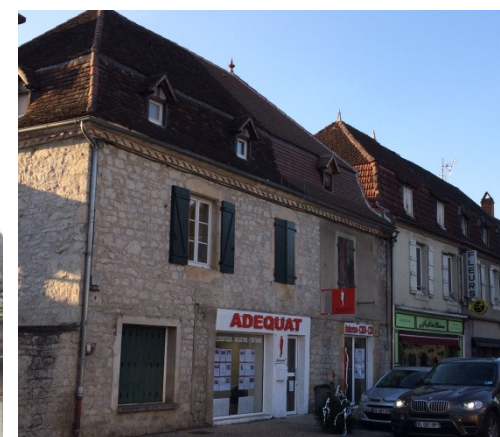
Exemple de toits à combles brisés soulignés d'une génoise. A noter que, dans le premier exemple les abouts de solives destinés à supporter les chevrons en débord ont été sectionnés pour permettre la mise en œuvre d'une génoise.
