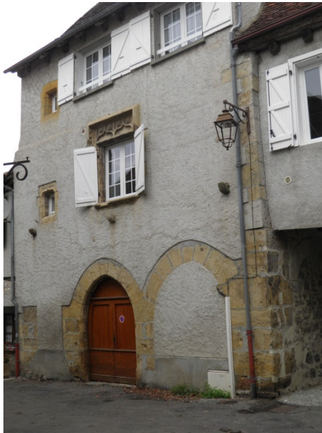
Maison p 214 (rue de la Guierle) : le rez-de-chaussée conserve deux arcades ainsi qu'une porte piétonne masquée par l'enduit, tandis que l'étage est percé d'une croisée surmontée d'accolades agrémentée de rose, motif récurrent du XV ème siècle. A noter la présence de corbeaux indiquant sans doute la présence d'un auvent attestant de la fonction commerciale du Rez-de-chaussée.
