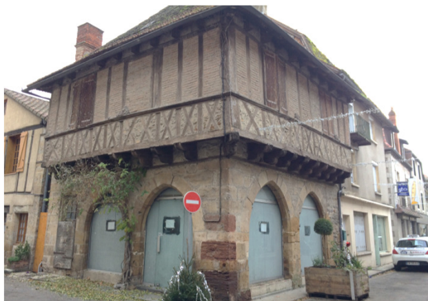
Exemple d'un toit à quatre pans, le coyau est porté par des abouts de chevrons moulurés
